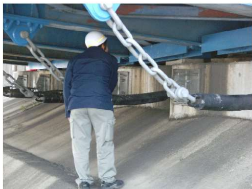
写真 3-3 職員による点検状況①
