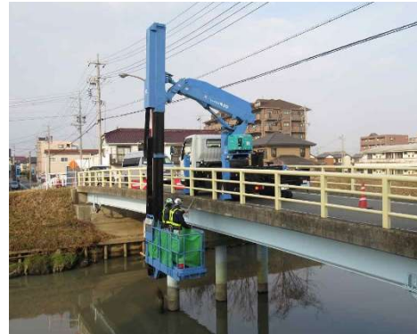
写真 3-2 専門業者による点検状況②
