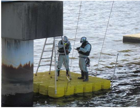
写真 3-1 専門業者による点検状況①
