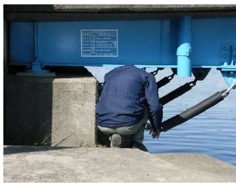
写真 3-4 職員による点検状況②
