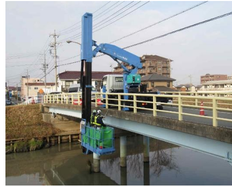
写真 3-2 専門業者による点検状況②
