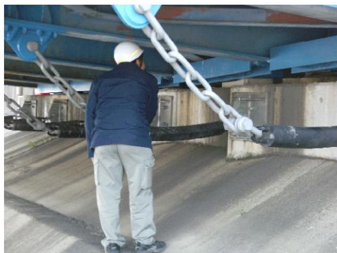
写真 3-3 職員による点検状況①
