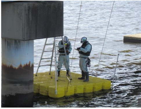
写真 3-1 専門業者による点検状況①
