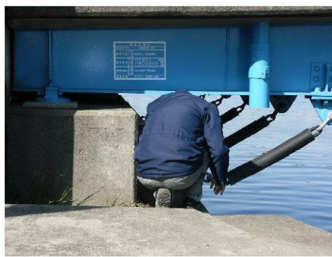
写真 3-4 職員による点検状況②
