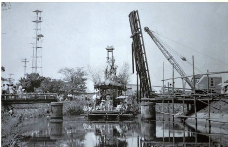
祭船を通すため、クレーンで持ち上げられた旧御葭橋(昭和47年頃)
