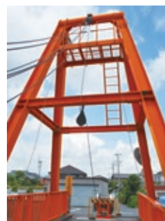
滑車とワイヤーを設置
