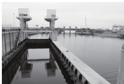
▲旧水門の撤去工事が進められています (水門から日光川方面を臨む)
