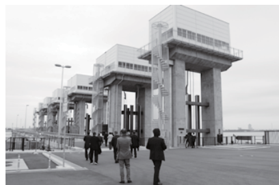
▲水門を視察しました
