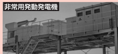
非常用発動発電機 災害非常時に、3日間センター機能を維持する電力を供給
