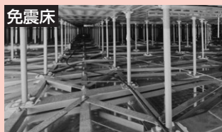
免震床 指令室に導入され、機器類の転倒や破損を防ぐ
