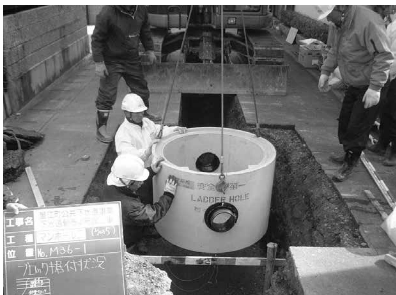
▲下水道工事の様子
