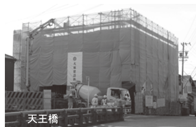
▲建設中の観光交流センター（須成地区）
