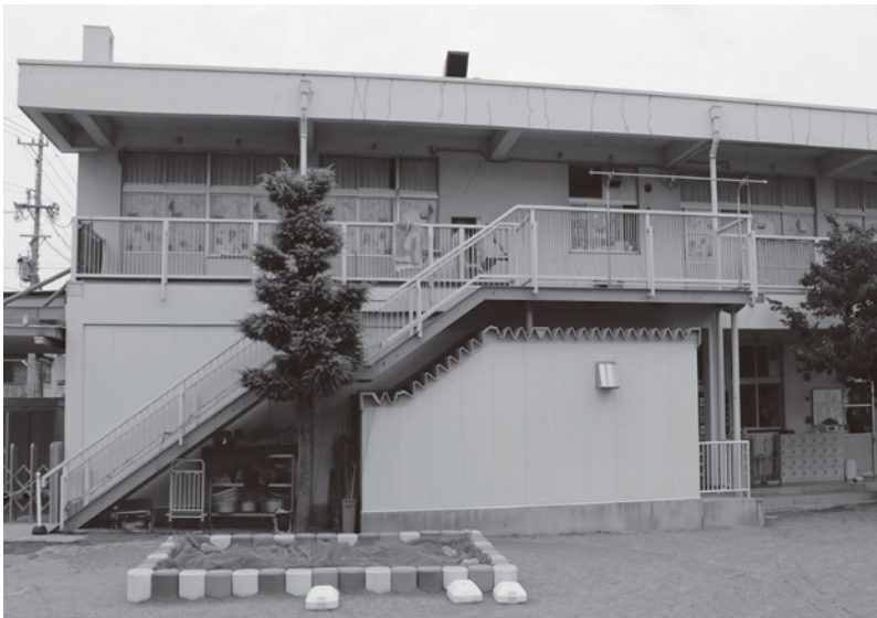
▲昭和49年に建てられ、築43年が経過している蟹江保育所
