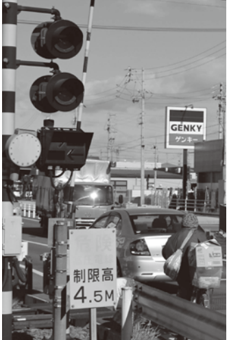
▲改良すべき踏切道に指定された東郊線踏切道
