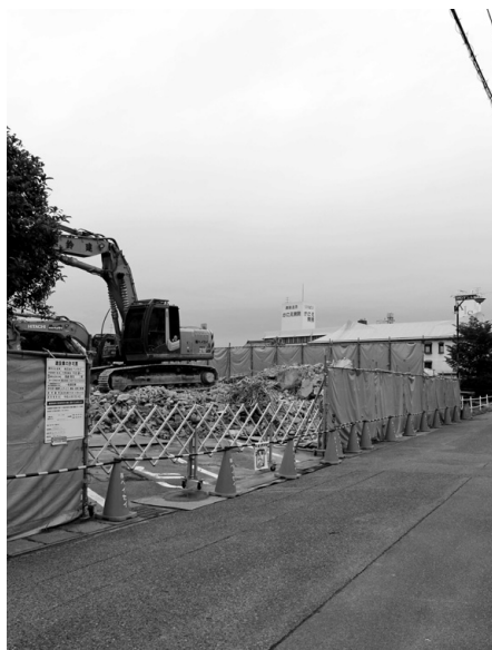
▲解体が進む福祉センター分館
