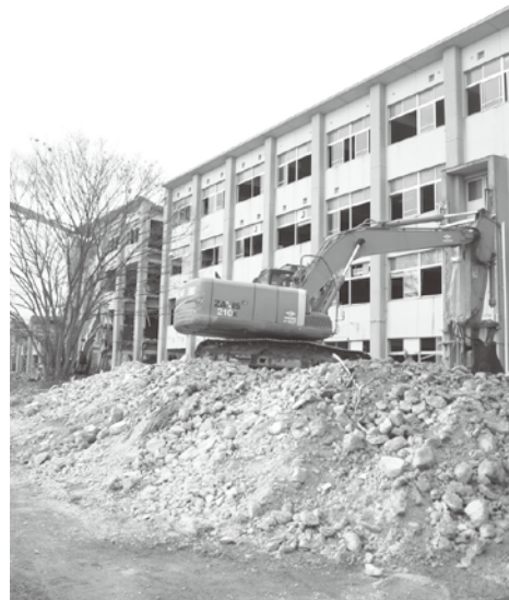
▲解体が進む北校舎
