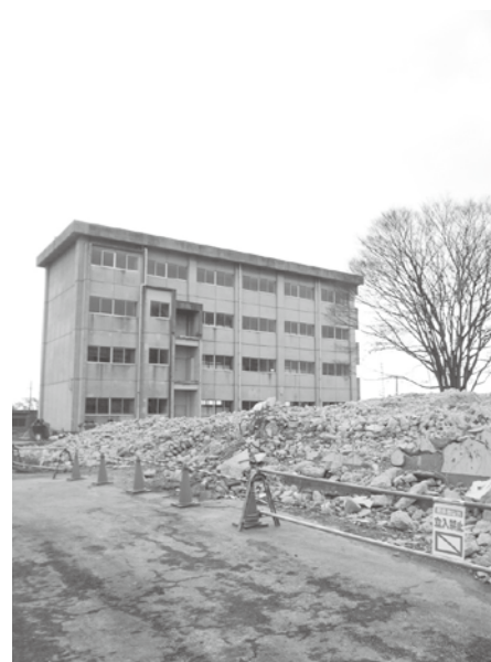
▲改修工事が行われる予定の南校舎
