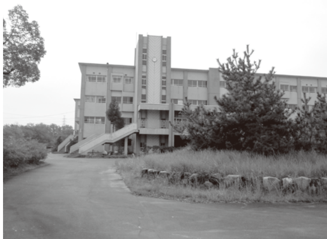
▲解体工事が始まる旧蟹江高等学校
