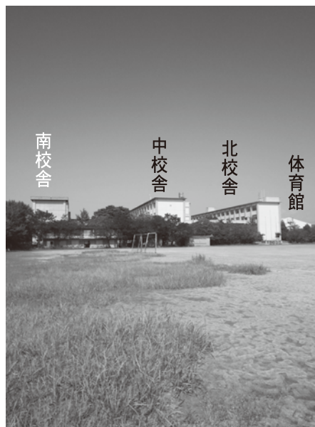
▲取壊しされる体育館・北校舎・中校舎と改修される南校舎
