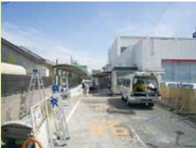
▲着々と工事が進む駅前駐輪場 (7月6日撮影)
