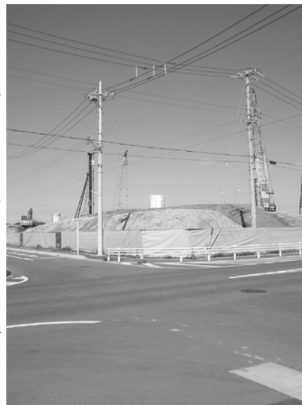
▲着々と建設が進む新ヨシヅヤ蟹江店
