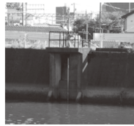
▲今回撤去される樋門
