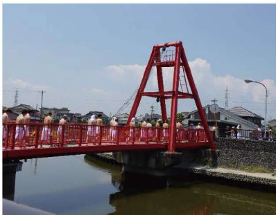
みそぎで水を浴びて御葎橋を渡る
