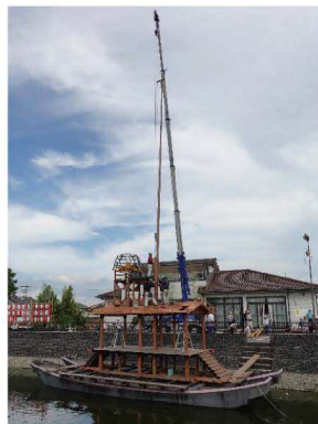
クレーンで真柱を立てる
