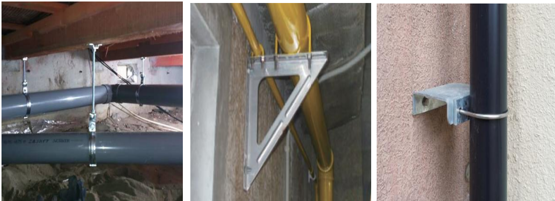
吊り・横主管・立管の施工写真〔例〕
