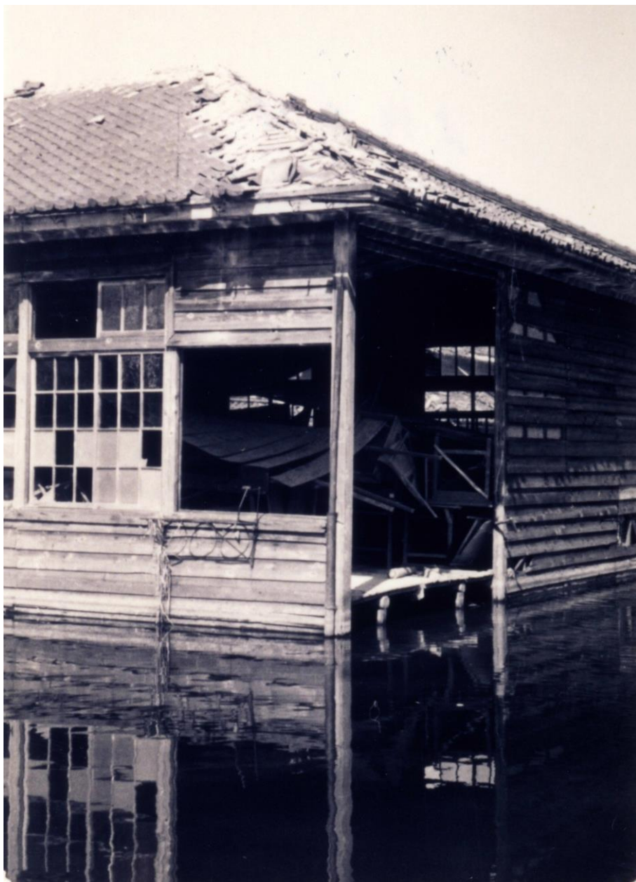
被災した蟹江小学校
