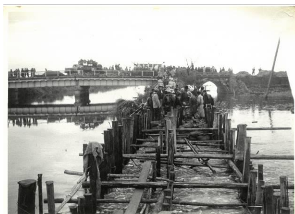
修理 しゅうり される堤防 ていぼう (本町十丁目)
