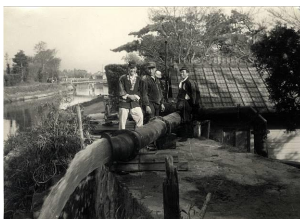
ポンプによる排水 はいすい (須成)
