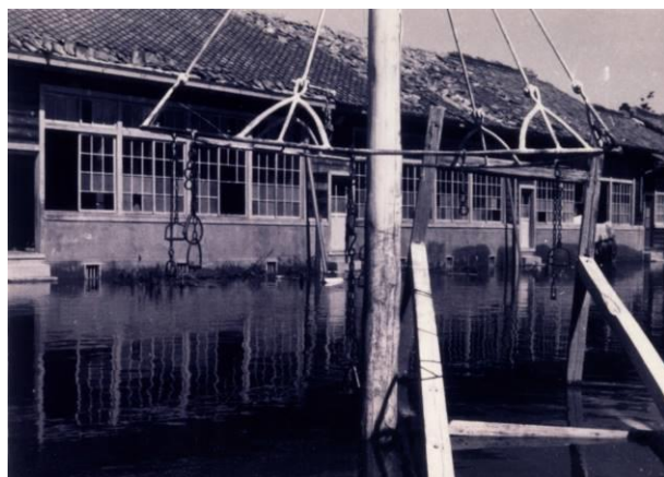
水没した須西小学校(須成西六丁目)
