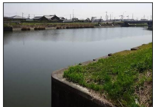
かにえがわひもん こうもんあと 蟹江川樋門・閘門跡
