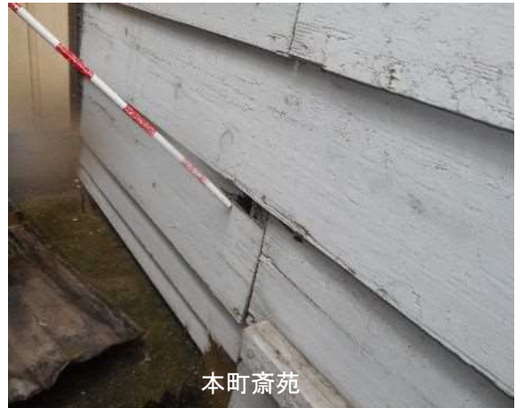
板張り外壁の腐朽、破損
