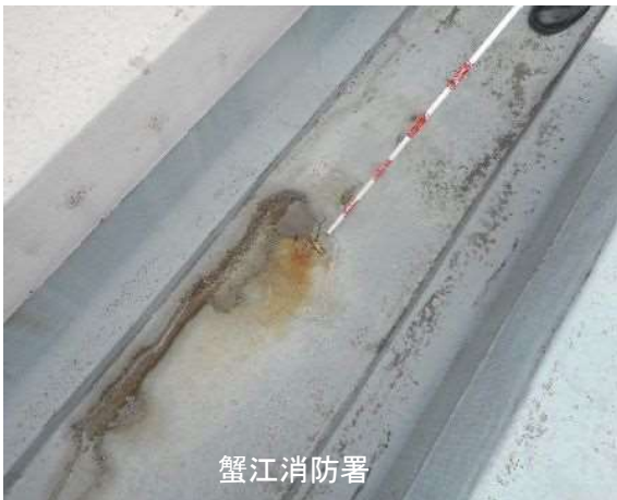
屋上防水層の破損、雨漏り
