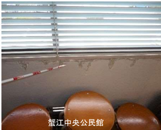
内装クロス剥がれ、汚損
