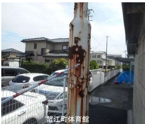
外灯支柱の腐食
