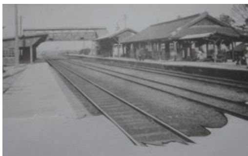
明治28(1895)年に関西鉄道の駅として開業。当時は、蟹江停車場と呼ばれていました。(写真は昭和10年代)
