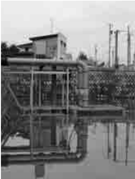
▲蟹江今駅北特定土地地区画整理地内の調整池に新設された排水ポンプ
