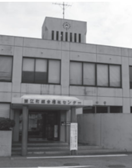
▲老朽化著しい老人福祉センター本館
