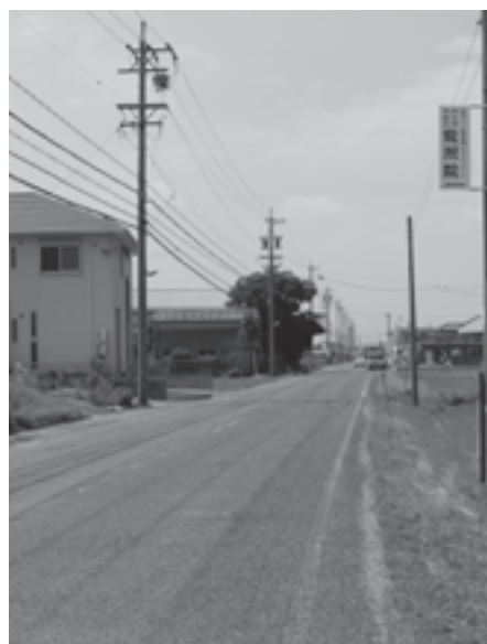
▲道路拡幅、歩道設置が望まれる今須成線
