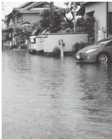
▲平成24年8月の豪雨で冠水した道路
