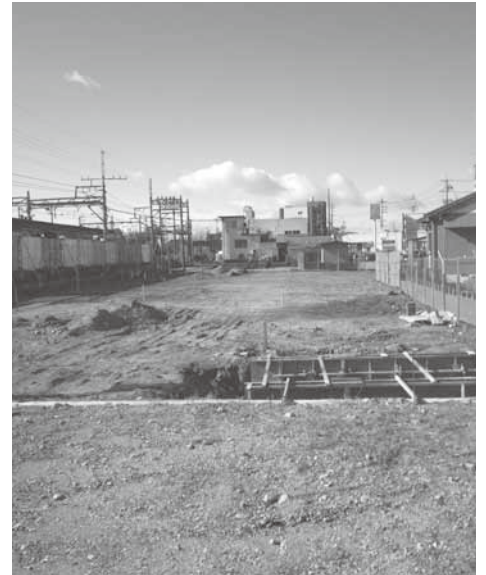
▲建設中の仮自転車駐輪場
