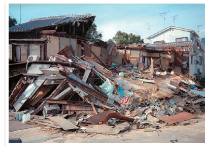
Grande Terremoto Hanshin-Awaji
