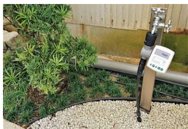
コントローラ と 吐水孔付きポリチューブ
