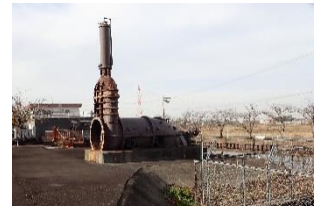
蟹江大湊排水機場 昔使われていたポンプ
