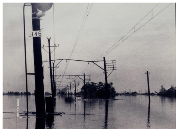
近鉄蟹江駅付近の被災状況
