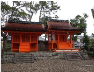
富吉建速神社本殿・ 八劔社本殿
