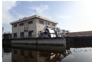
蟹江大湊排水機場
